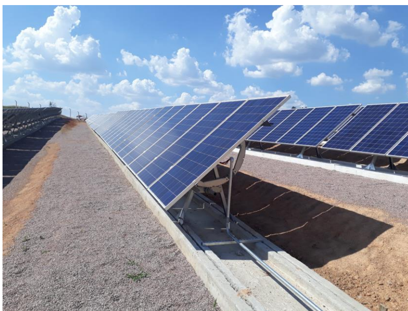
Figura 4.6: Estrutura de fixação Tracker
